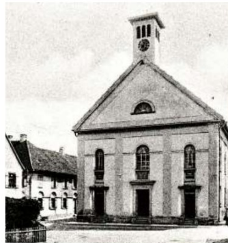
Das ursprüngliche Synagogen-Gebäude. FOTO: ARCHIV CHARLOTTE MAYENBERGER
